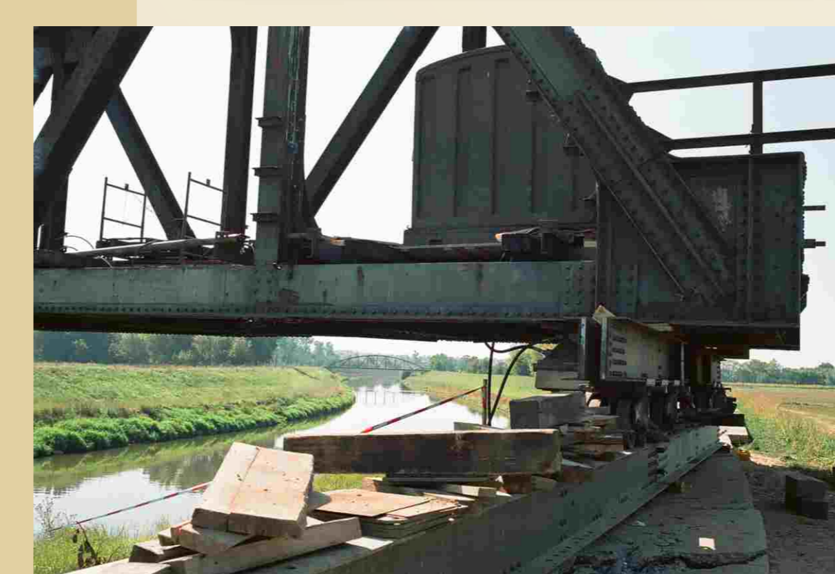
Přesun mostu v r. 2001
