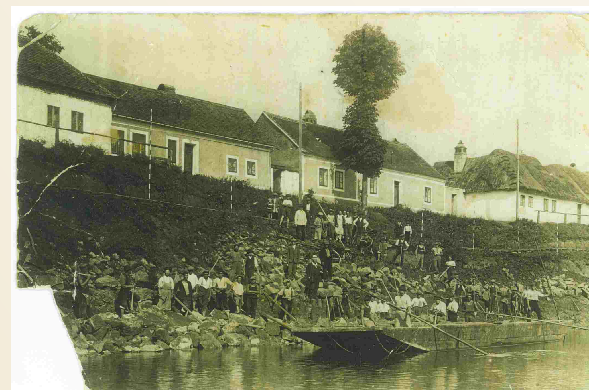
Úprava řečiště Moravy ve Veselí nad Moravou v letech 1920 - 1925
