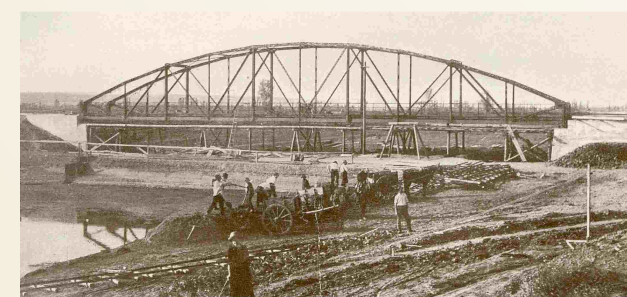
Stavba železného mostu u Zarazic v r. 1912
