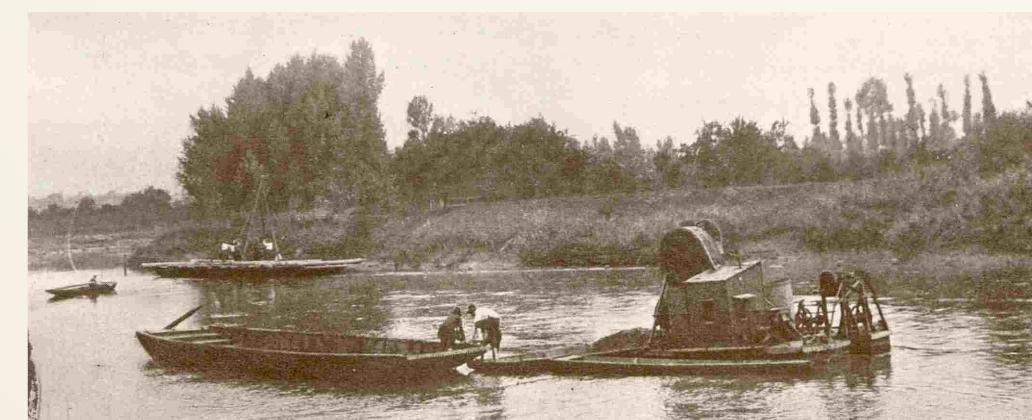
Prohlubování řečiště plovoucím rypadlem a opevňování břehů
