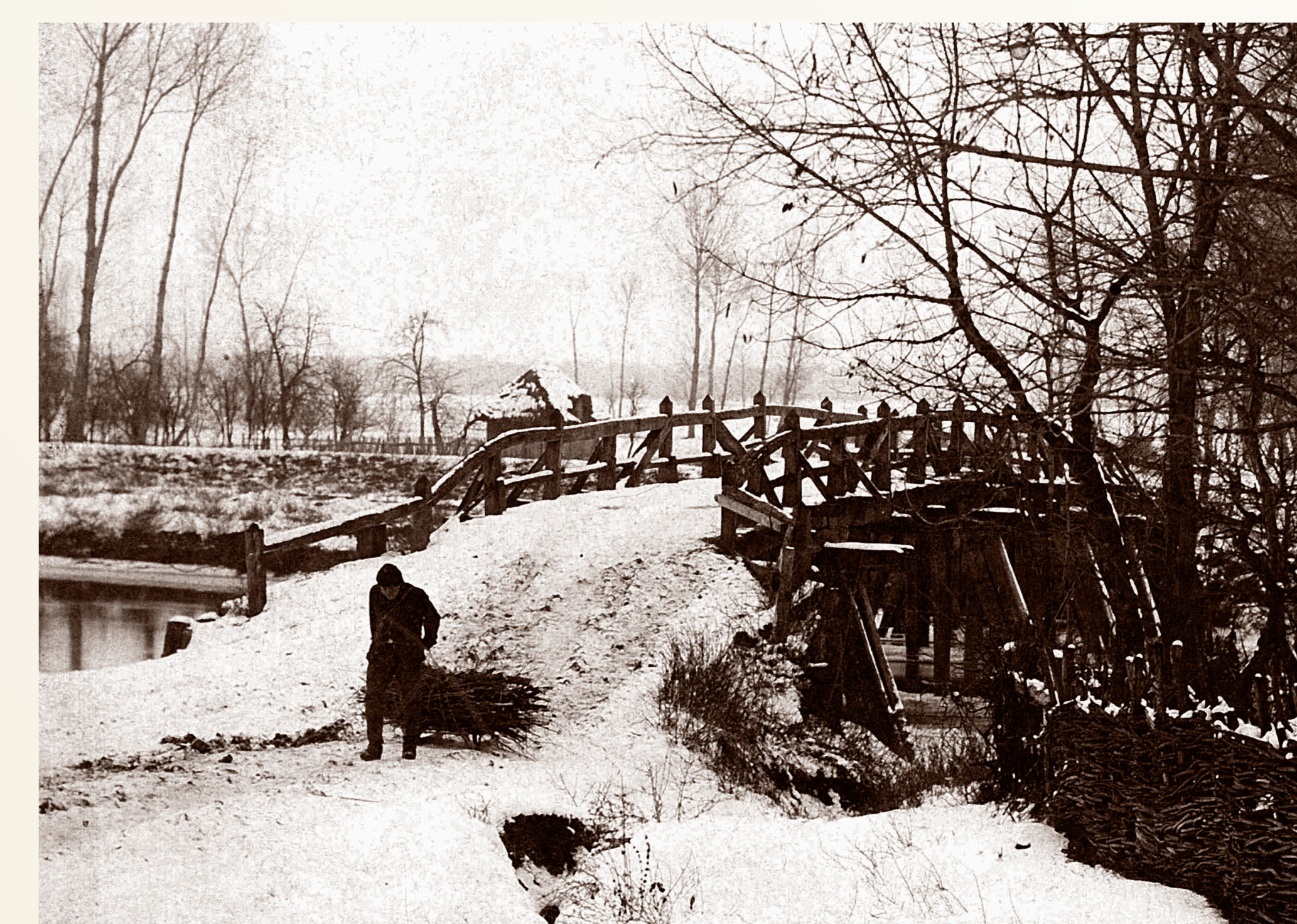
Původní dřevěný most přes řeku Moravu v Zarazicích
