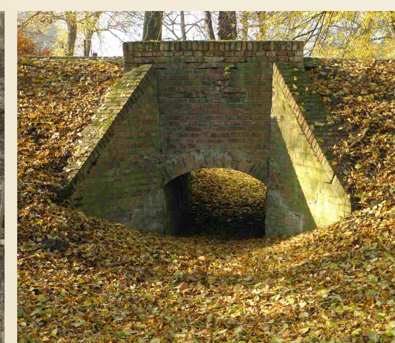
Propustek v železničním náspu
